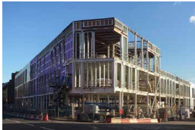
Site construction image.
